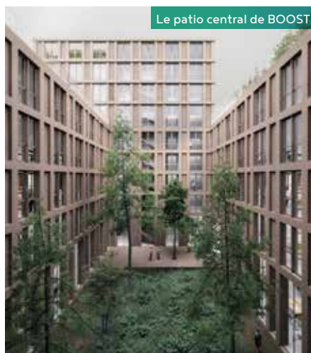
Le patio central de BOOST
